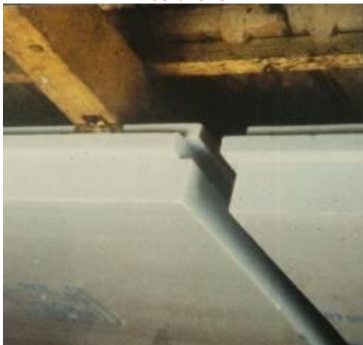
Afbeelding 18 – na-isoleren zonder (ersatz-) onderdak: af te raden
