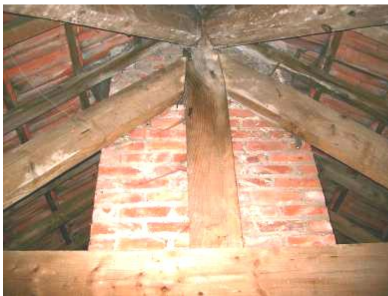
Afbeelding 15 – voorbeeld van een bestaande kapconstructie vóór na-isolatie van het dak
