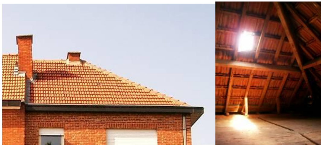
Afbeelding 16 – voorbeeld van een hellend dak zonder onderdak
