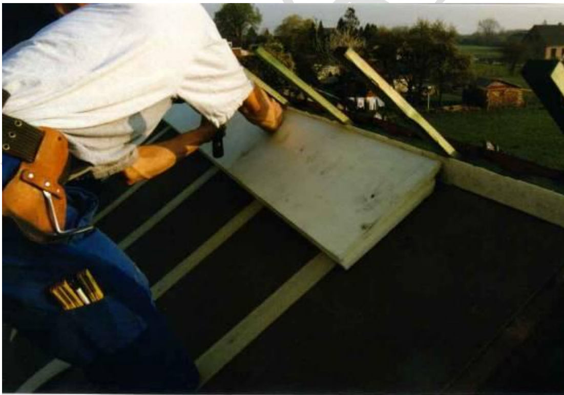
Afbeelding 36 - Plaatsing en eerste bevestiging van de isolatieplaten
