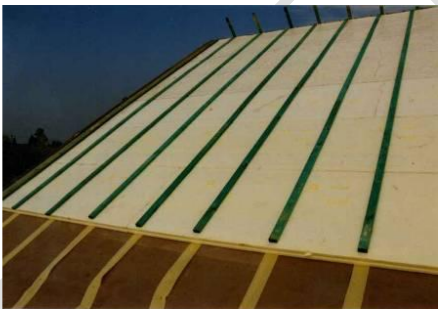
Afbeelding 37 - Definitieve bevestiging van de isolatieplaten met tengellatten
