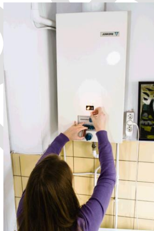
Figure 4 : chauffe-eau à circuit de combustion ouvert
