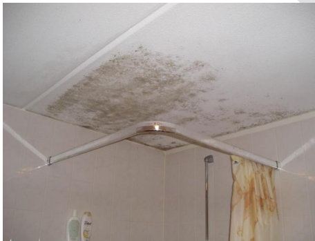
Figure 6 : exemples de problèmes d'humidité qui doivent attirer l'attention
