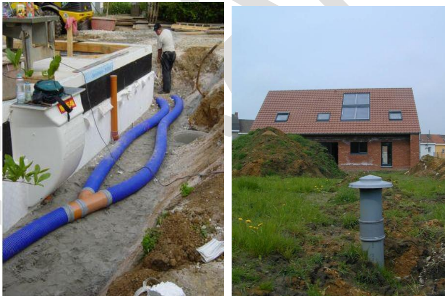
Figure 33 : pose d'un puits canadien
