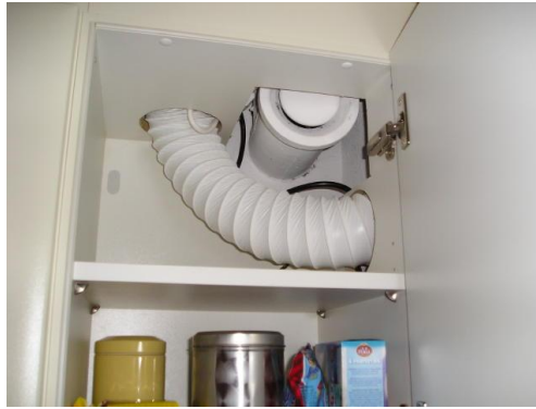
Figure 22 : pose de conduits dans un placard (attention : conduits flexibles non conseillés)
