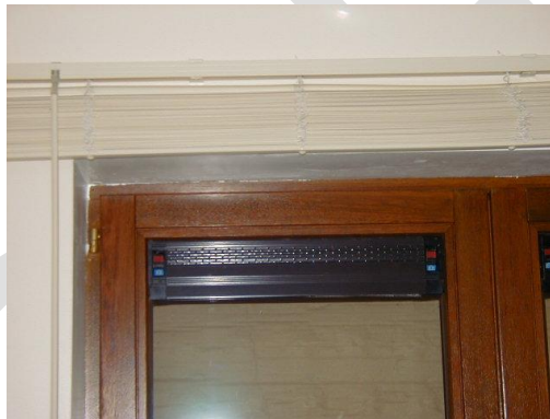
Figure 15 : une grille de ventilation existante placée lors d'un changement de châssis
