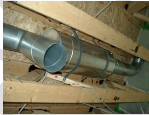
Figure 20 : exemple de pose de conduits dans des espaces libres
