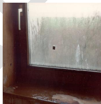
Figure 6 : exemples de problèmes d'humidité qui doivent attirer l'attention
