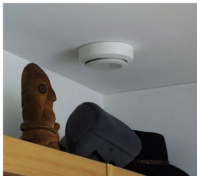
Figure 24 : exemple de bouche de pulsion
