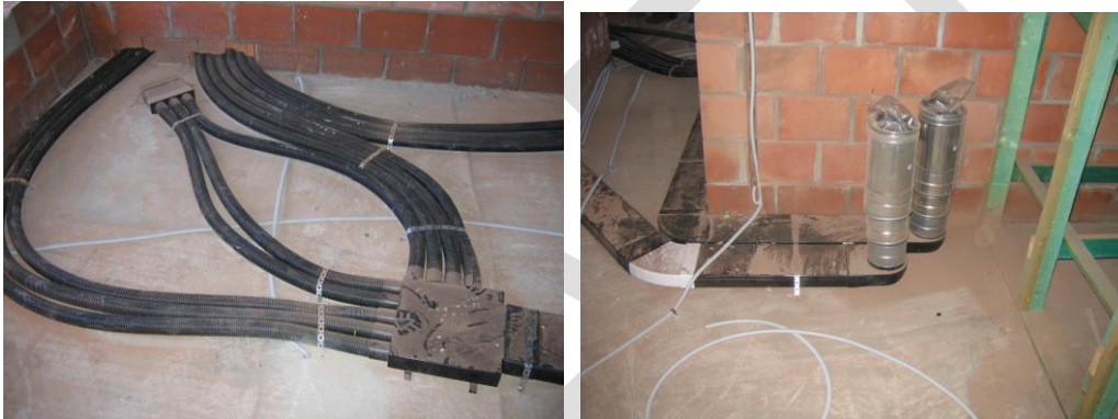
Figure 23 : conduits en chape
