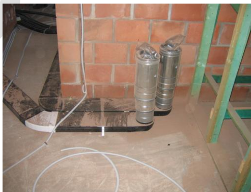
Figure 41 : conduits enchape
