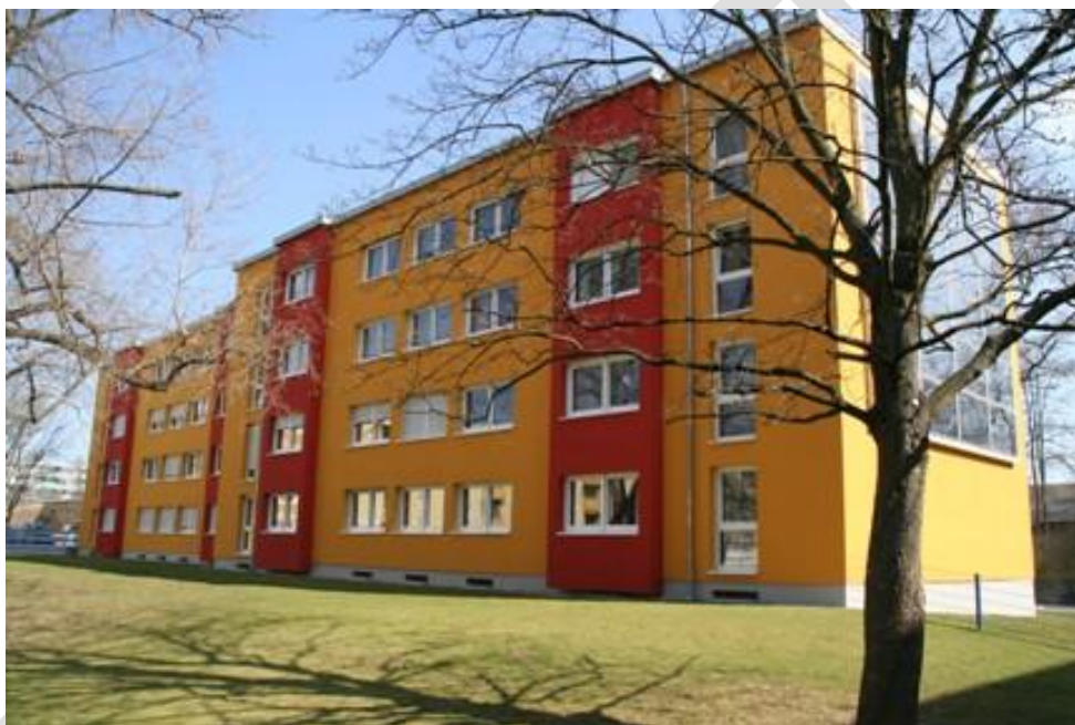
Figure 25 : bâtiment à Ludwigshafen (Allemagne) dont la ventilation a été rénovée par pose d'amenée d'air en façade (invisible sous l'isolation)
