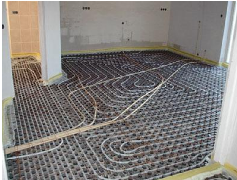
Figure 42 : la pose des tuyaux du chauffage par le sol, avant de couler la chape
