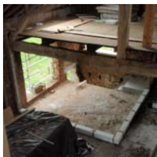
Terrasse au 1er étage, nouveau plancher au 2ème.
