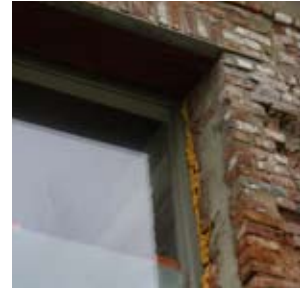
Injections de mousse isolante dans les joints entre les châssis et les murs.
