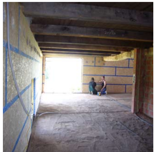
Bandes adhésives étanches sur les joints des panneaux OSB - couche de sable sur le plancher pour isolation acoustique.
