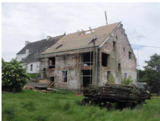
Rénovation de la toiture.
