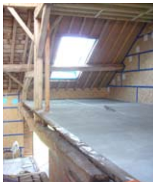
Cellulose insufflée derrière les panneaux OSB.
