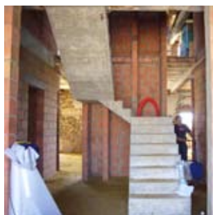
Noyau central vu du rez-de-chaussée.
