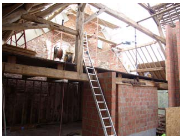
1er et 2ème étage - mise en place du nouveau plancher et des caissons où la cellulose sera insufflée.
