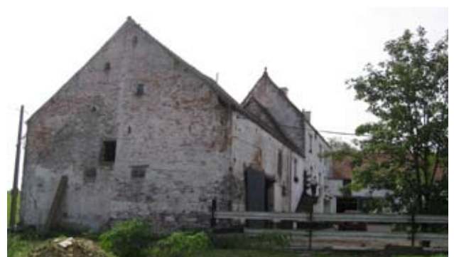
Bâtiment A avant rénovation.
