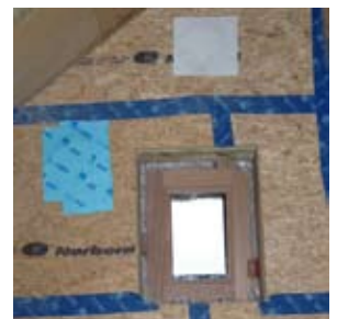
Bandes adhésives étanches sur les joints des panneaux OSB et sur les trous d'insufflation.
