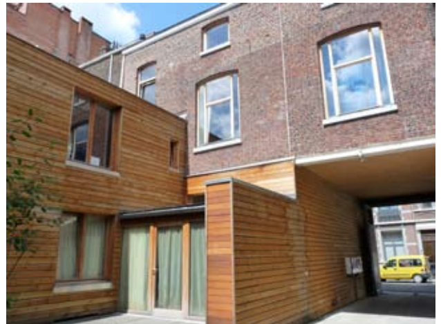
Façade arrière et annexe après rénovation.
