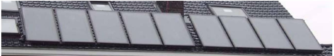
Panneaux solaires thermiques.
