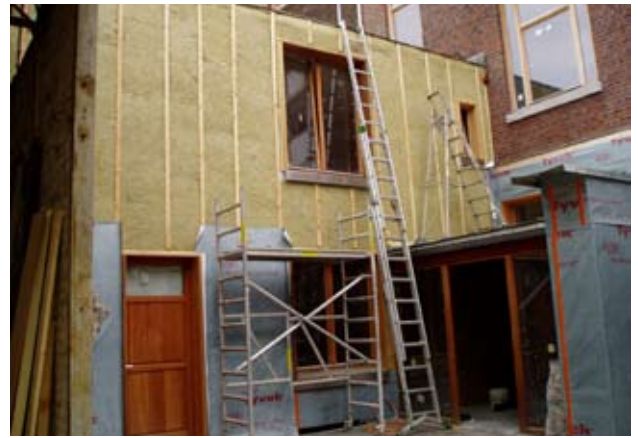
Isolation par l'extérieur et étanchéité de l'annexe.
