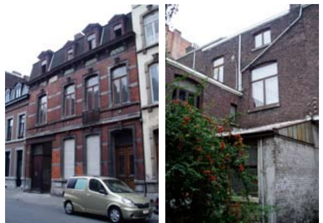
Façade avant et annexe avant rénovation.
