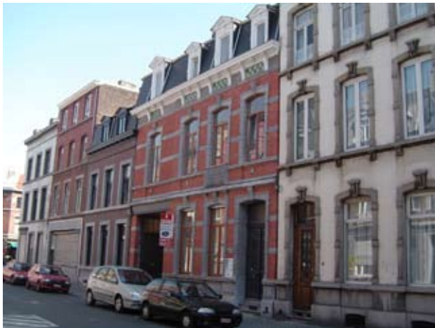
Façade avant après rénovation.
