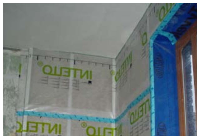
Freine-vapeur et étanchéité à l'air.
