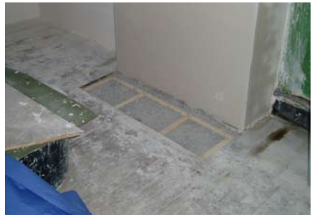
Isolation des planchers intermédiaires en cellulose.
