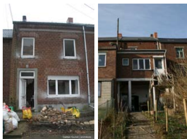
Façade avant et arrière avant rénovation.
