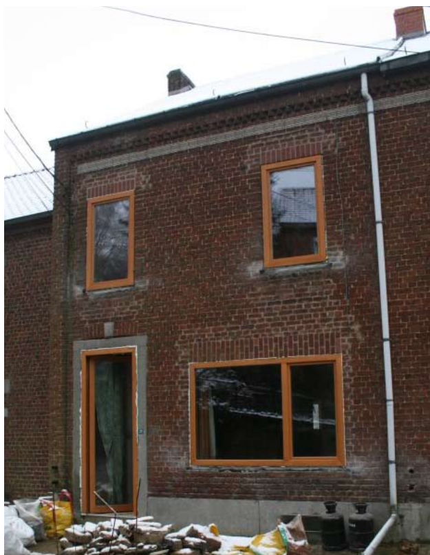
Les nouveaux châssis ont été placés à fleur du mur en brique. La façade doit encore être isolée.
