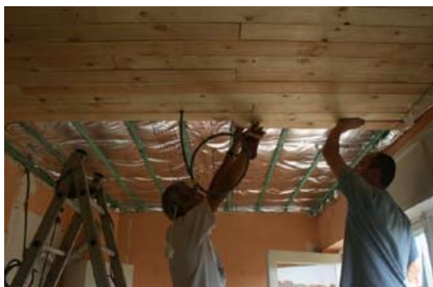
En phase 1, la toiture de la cuisine est déjà isolée à titre provisoire.
